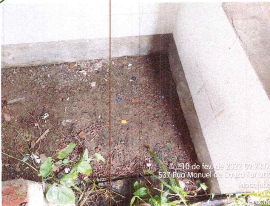
Imagem 23 – Vista da área interna da obra.
