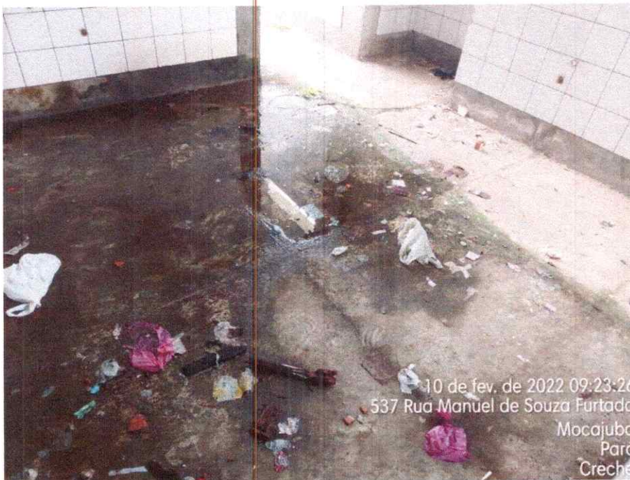
Imagem 24 – Vista da área interna da obra.
