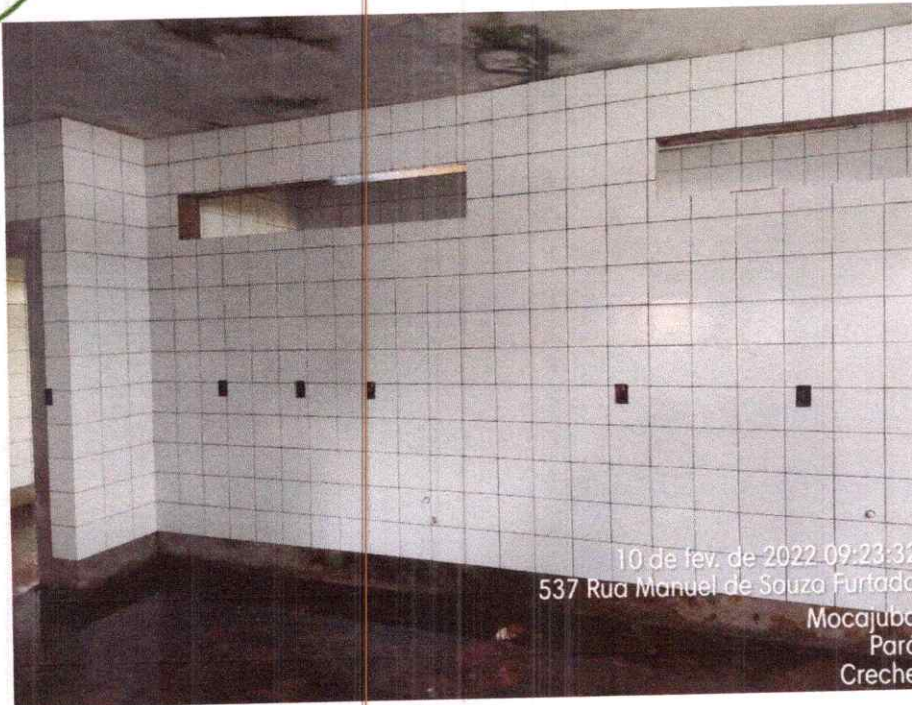
Imagem 25 – Vista da área interna da obra.
