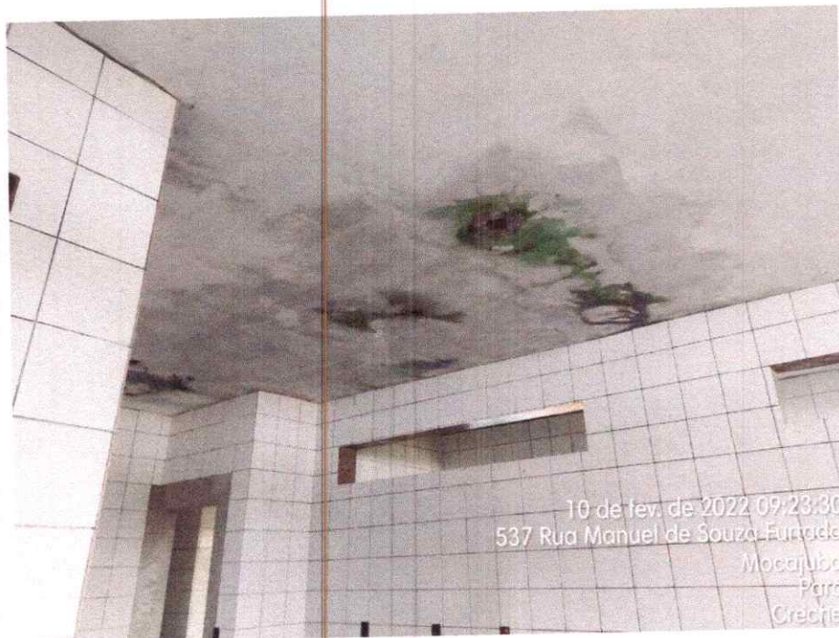
Imagem 26 – Vista da área interna da obra.
