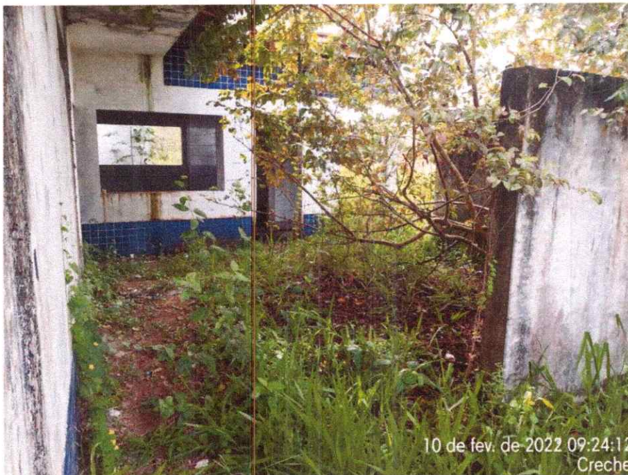
Imagem 28 – Vista da área externa da obra.
