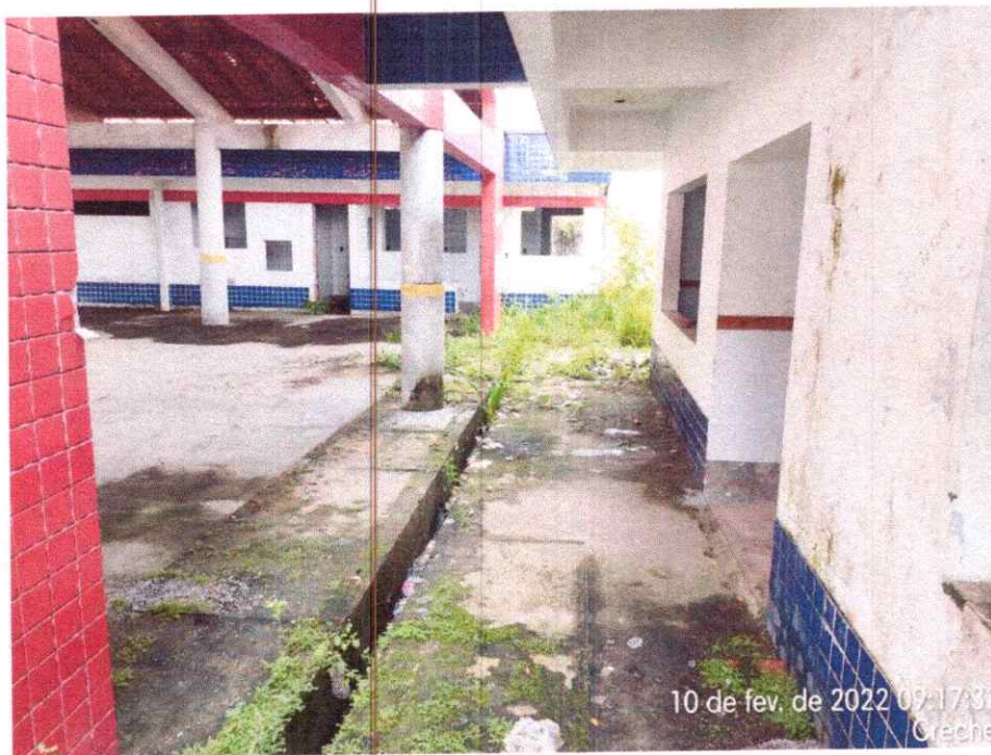
Imagem 15 – Vista da área interna da obra.
