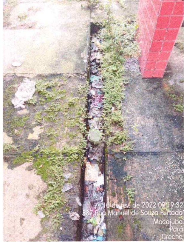
Imagem 17 – Vista da canaleta interna.
