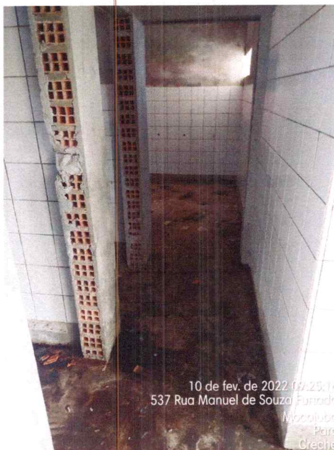
Imagem 32 – Vista da área interna da obra.
