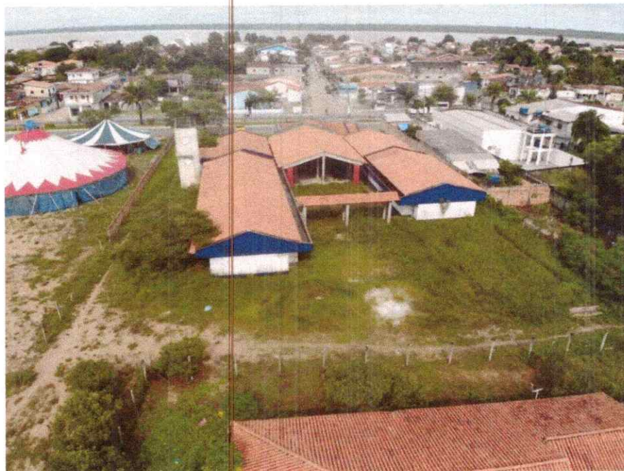
Imagem 02 – Vista aérea dos fundos da obra.
