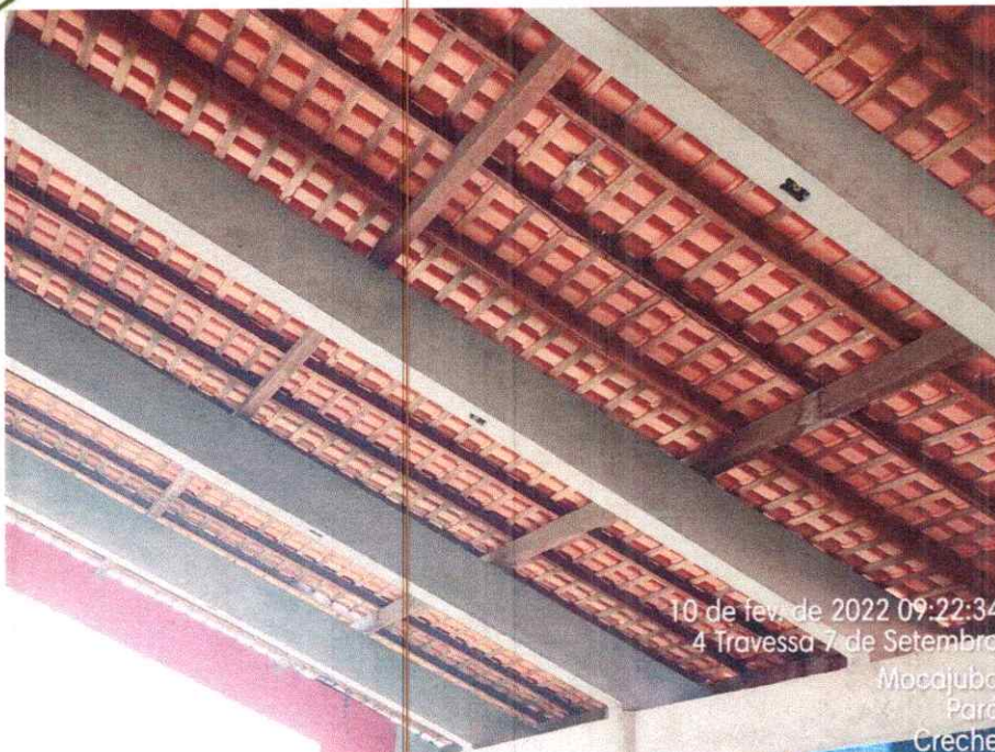
Imagem 21 – Vista do telhado do pátio coberto.
