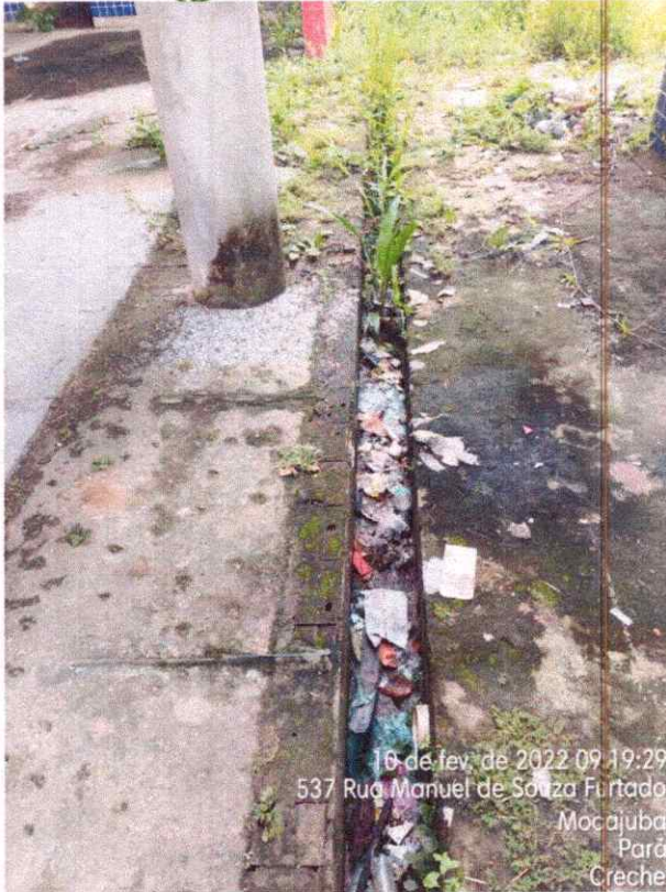
Imagem 16 – Vista da canaleta interna.
