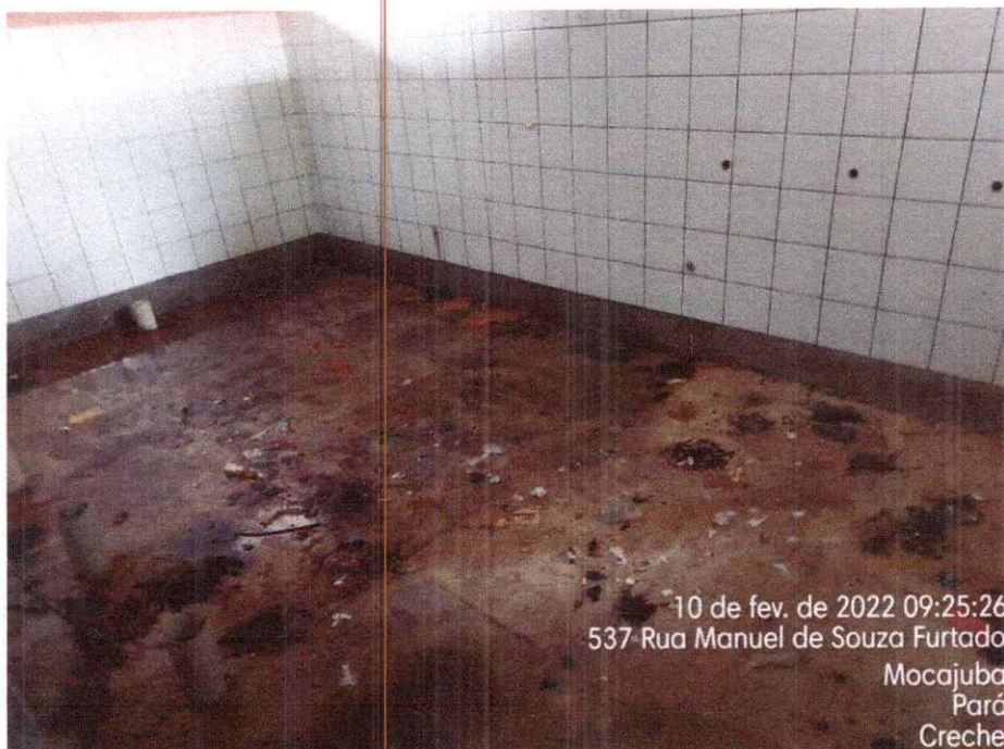
Imagem 33 – Vista da área interna da obra.
