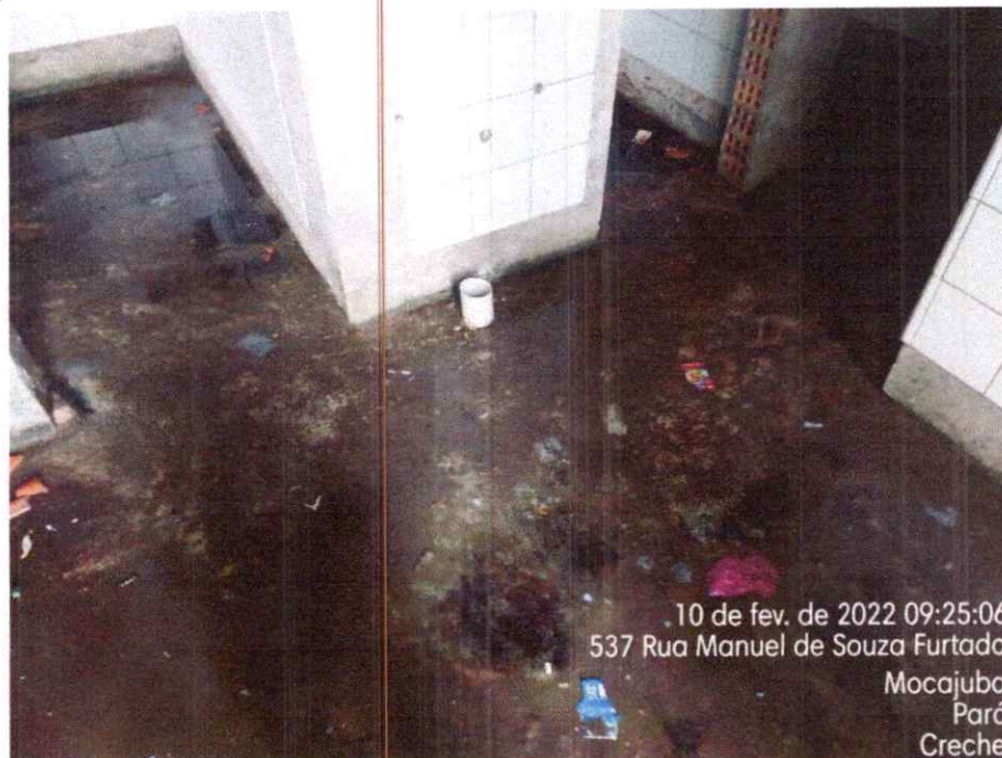
Imagem 31 – Vista da área interna da obra.
