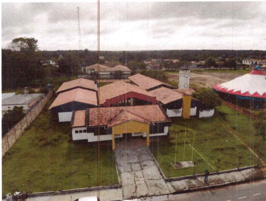
Imagem 01 – Vista aérea frontal da obra.
