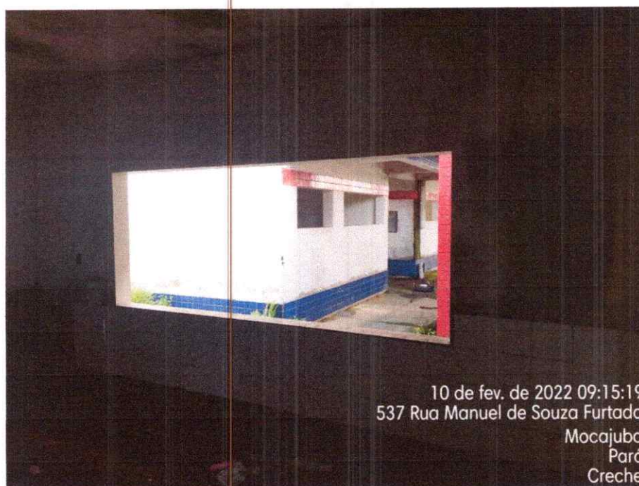
Imagem 09 – Vista da área interna da obra.
