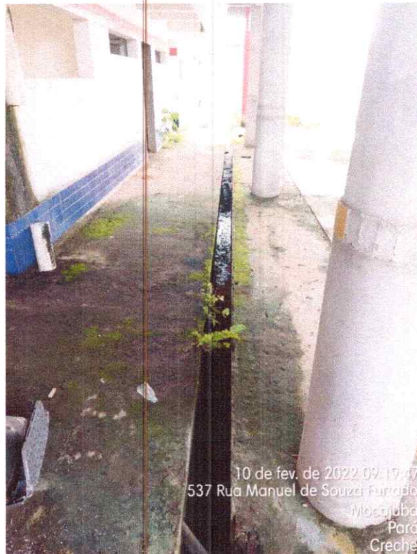
Imagem 18 – Vista da canaleta interna.
