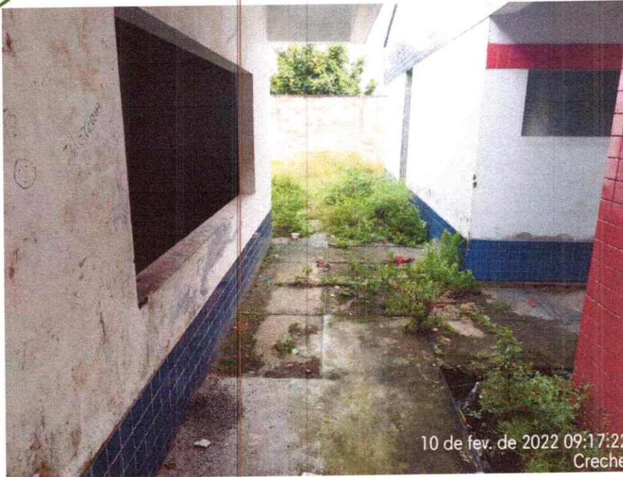
Imagem 14 – Vista da área interna da obra.
