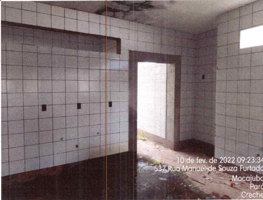
Imagem 27 – Vista da área interna da obra.
