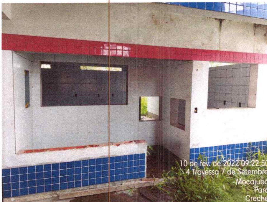
Imagem 22 – Vista da área interna da obra.
