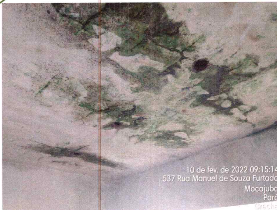
Imagem 08 – Vista da área interna da obra.
